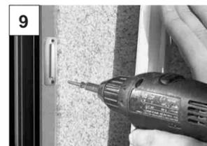
9 È possibile, qualora fosse necessario, fissare le clips d'ancoraggio della zanzariera al telaio dell'infisso.
